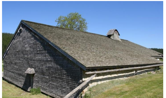
Toiture en tavaillons / Tuyé / Talevanne sud en tavaillons / Ferme semi-enterrée
